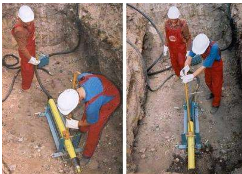
Рис. 5.8. Фотографии подготовки пневмопробойника ИП 4605А к выполнению работ по устройству выштампованной микро сваи
