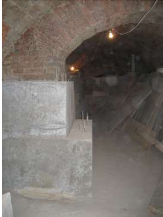
Рис. 5.11. Фотография внутренней кирпичной стены подвала здания после реконструктивных работ по углублению подвала с устройством выштампованных микро свай усиления основания и железобетонной вертикальной прижимной стенки (см. расчётную схему на рис. 5.9)
